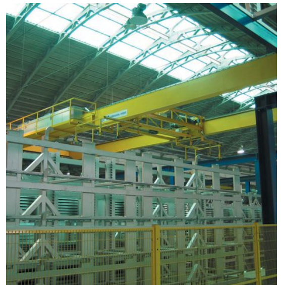
Transport von Profilkörben mit Hilfe des Automatikkrans
