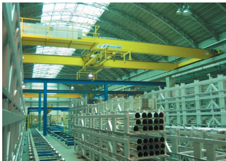
Anbindung an das Werk Feltre: Lagerbereich und dreiachsiger Automatikkran Nr. 5
